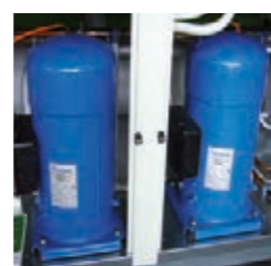
Compressori Scroll. Scroll compressor.
