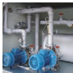
Elettropompa d'emergenza. Safety pump (optional).
