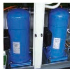
Compressori Scroll. Scroll compressor.
