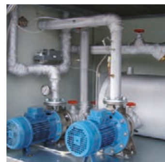
Elettropompa d'emergenza. Safety pump (optional).
