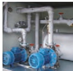
Elettropompa d'emergenza. Safety pump (optional).
