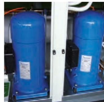
Compressori Scroll. Scroll compressor.
