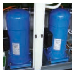
Compressori Scroll. Scroll compressor.
